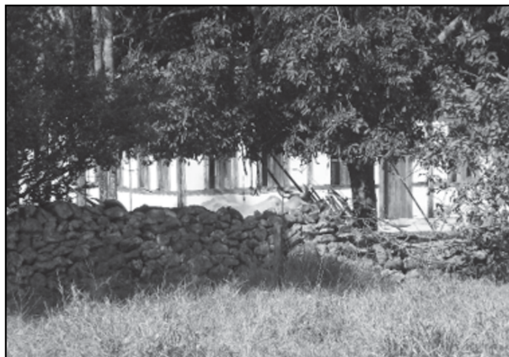
Muro de pedras, fazenda na região do Engenho Velho. Acervo Cida Sanches
