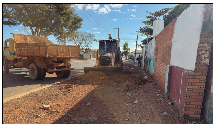
A parte externa da escola também está sendo reformada
