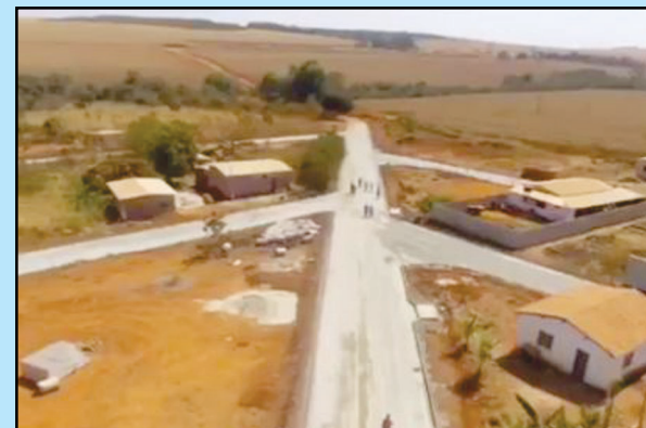
Pavimentação asfáltica e sinalização de todas as ruas do Distrito de Mocambinho
