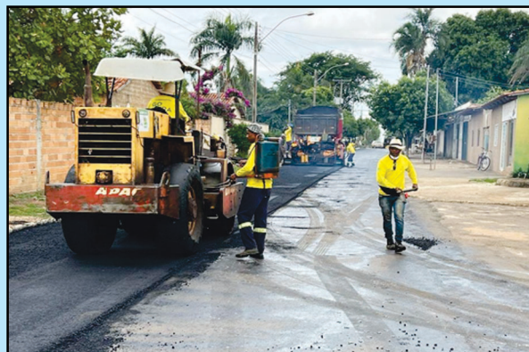
Pavimentação e recapeamento asfáltico de todas as ruas de Gameleira de Goiás
