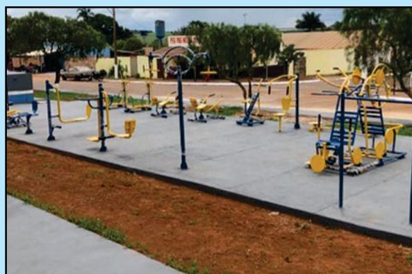
Construção da Academia ao Ar Livre do Mocambinho e em seu entorno foi feita uma pista de caminhada
