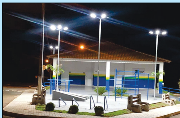
Construção da Academia de Saúde Manoel Lobo, no Distrito do Mocambinho, mais um equipamento importante para saúde e bem-estar da população
