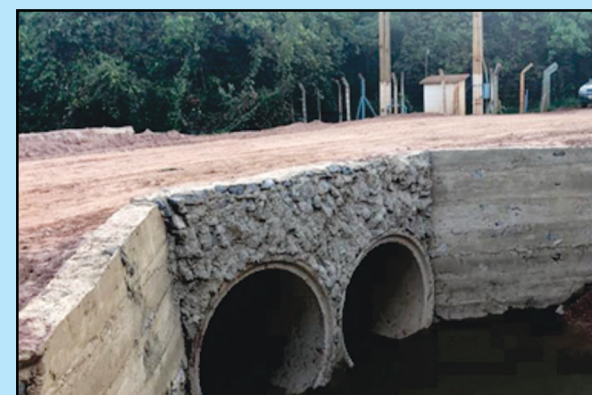
Construção de ponte, em 2018, a primeira da gestão atual, fruto de parceria entre a Prefeitura e a iniciativa privada
