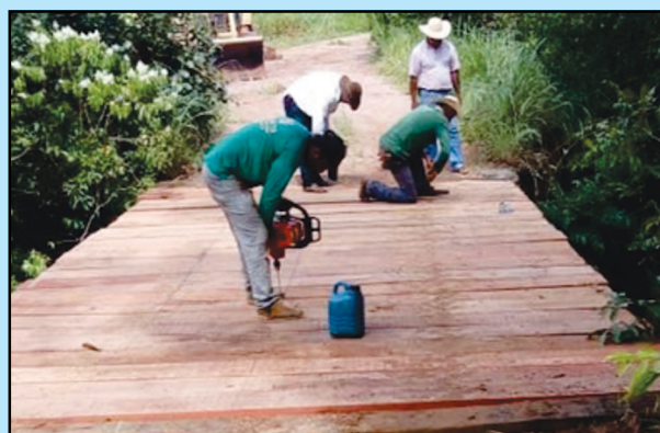
Reforma de ponte no Córrego Mocambo, uma das inúmeras intervenções realizadas nessa área em todas as regiões do município
