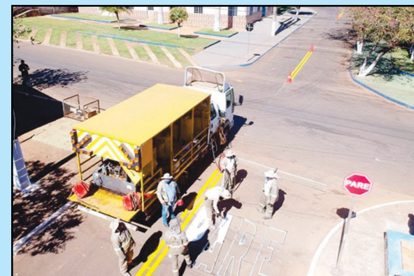
Gameleira recebeu nova sinalização horizontal e vertical por meio do Programa Sinaliza Goiás
