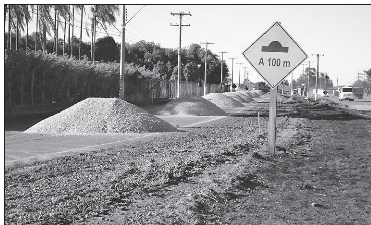
Entrada da cidade ganha asfalto novo.
