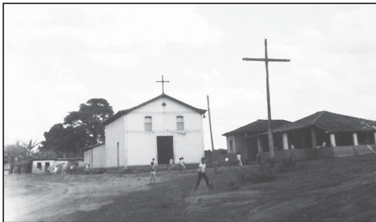
Igreja de São Sebastião, ao lado o barração que foi construído para a realização da Festa que se tornou tradição na cidade. Do lado esquerdo a Estrada do Sal que passava bem próxima a Igreja. Foto: Data desconhecida.
