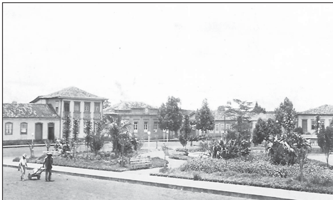
Jardim Público, a esquerda sobrado colonial que pertenceu ao Coronel Chiquinho. Demolido em 1942 para a construção da prefeitura. Foto encontrada no lixo por uma gari.
