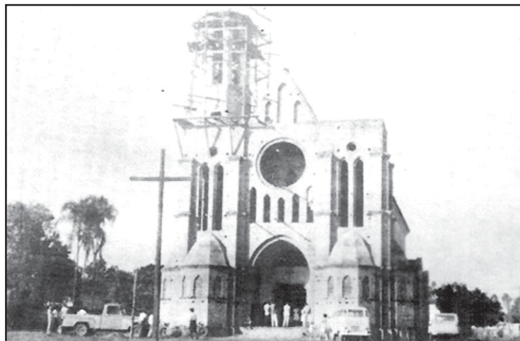
Igreja do Rosário em construção. Data provável: final da década de 50. Neste período já existia a Cruz em frente a construção.
