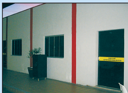
Conjunto de salas de atendimento ao público
