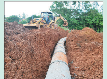
Cerca de R$ 4 mil foram investidos na instalação de 60m de galeria pluvial na passagem do Setor Pedrinhas para o Bairro Ermida Santo Antônio.
