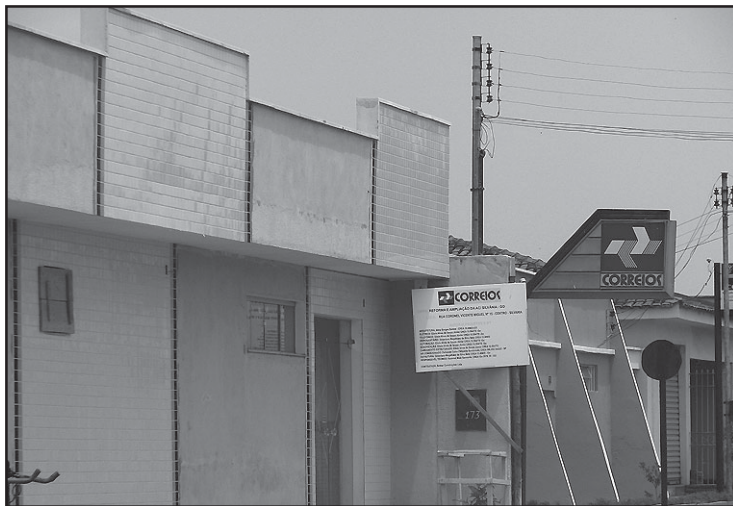
As obras de reforma e ampliação da Agência dos Correios em Silvânia continuam sem previsão de término. A entrega do novo prédio estava prevista para o mês de abril, mas as obras estão paralisada a cerca de cinco meses e não temos notícias de quando serão concluídas. Enquanto isso, os empregados e os clientes dos Correios e do Banco Postal se espremem na "sede" improvisada.
