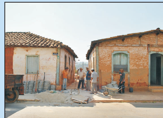
Prefeitura inicia obras de recuperação do Beco.
