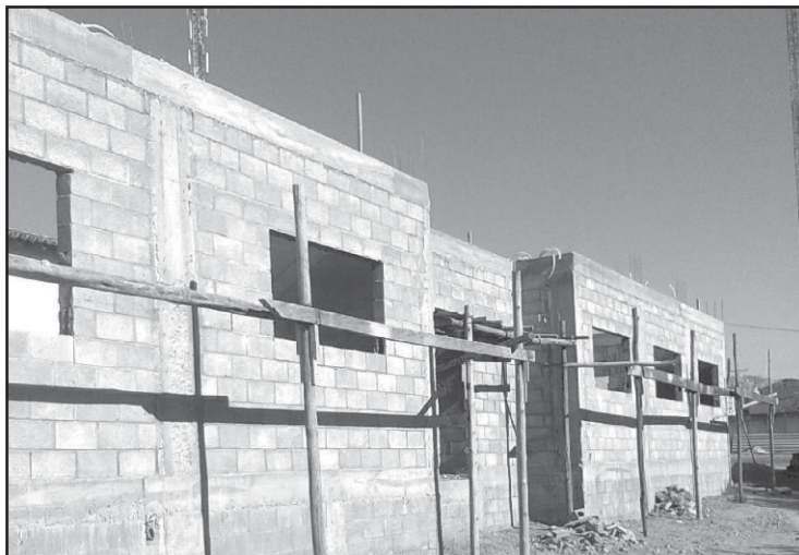
Já encontra em estado avançado a ampliação da sede da Central de Associações/Coopersil. Conforme aprovado na última assembleia geral da Central de Associações, foi vendido o imóvel de sua propriedade na rua Senador Canedo e o valor da venda está sendo aplicado na ampliação da sua sede, que contará com mais 200m 2 para melhor atender a seus sócios/cooperados.
