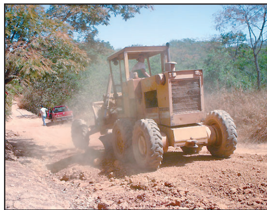
Região do Rio dos Bois recebe nova ponte.
