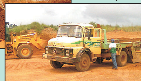
A AMASIL colaborou também com o transporte de cascalho para serviços realizados no centro urbano.
