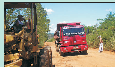
Máquina da Prefeitura Municipal trabalhando em cooperação com caminhões do conjunto AMASIL.
