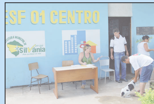
ESF 01 foi reformado recentemente.
