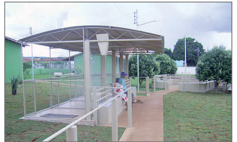
“Quintal” já coberto com grama e passarelas com corrimãos.
