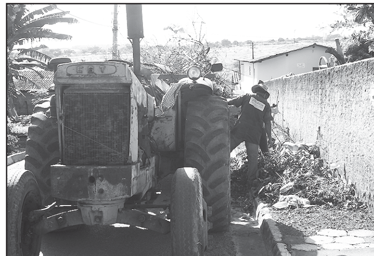
Retirada de entulhos.
