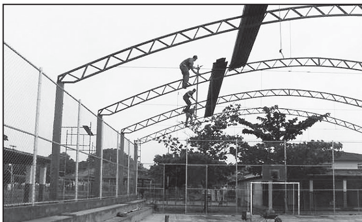
Cobertura da quadra: o sonho transformado em realidade.
