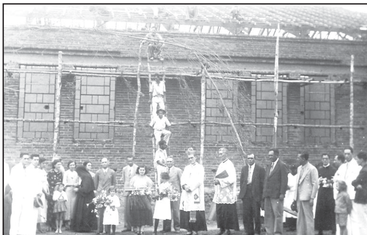
Foto da colocação da primeira telha no prédio do Instituto.
